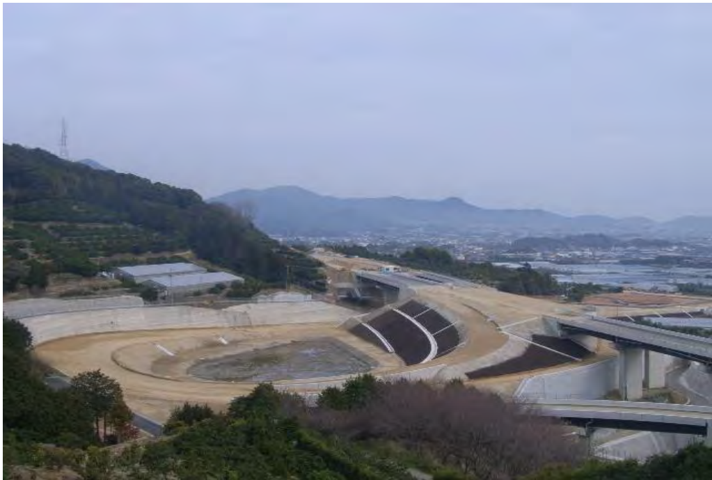
23号蒲郡BP蒲郡西ICランプ下部工事 78点
