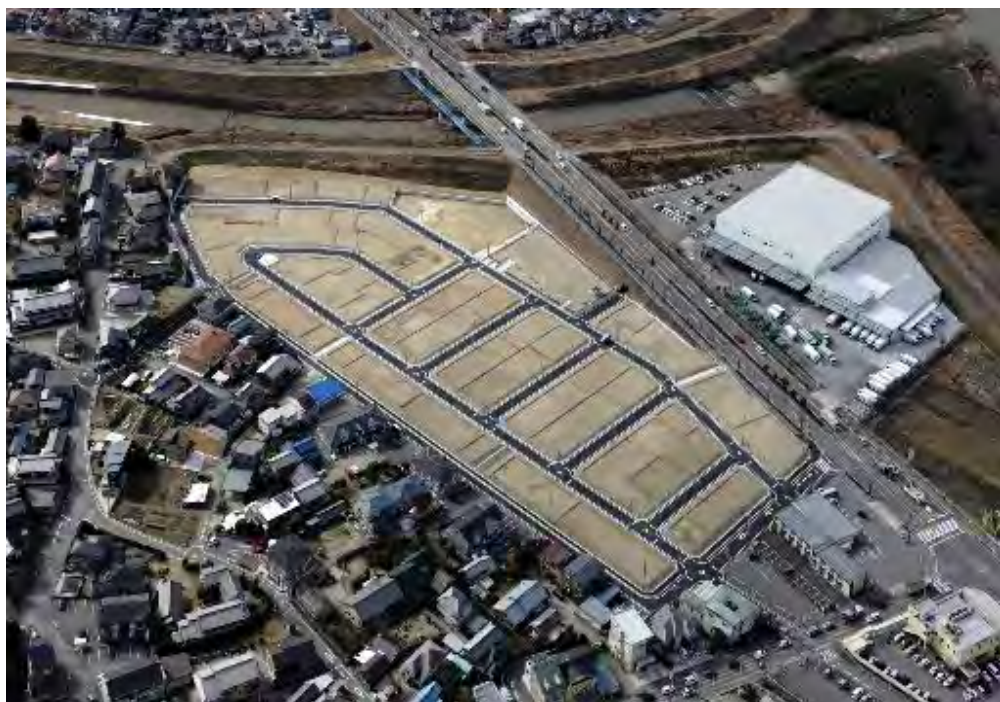
岡崎西蔵前住宅用地開発事業の内土地造成工事
