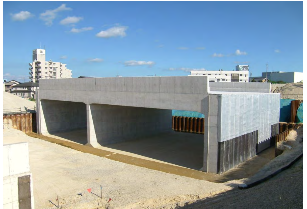
155号豊田南BP柿本道路建設工事 81点
