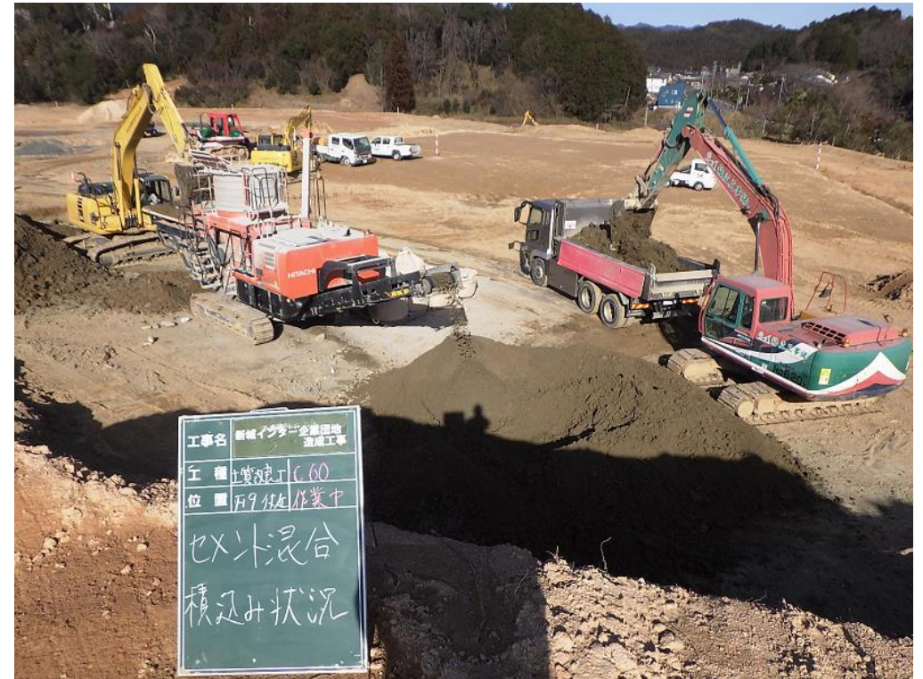
新城インターチェンジ企業団地造成工事
