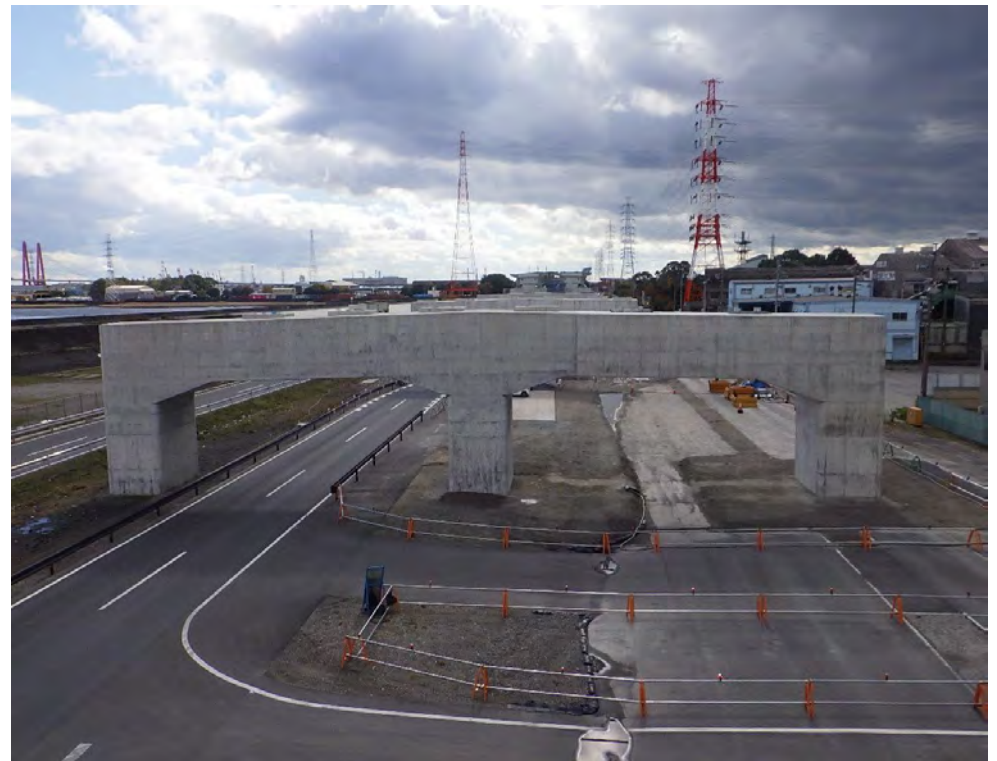
平成26年度 名二環新政成2高架橋下部工事 81点
