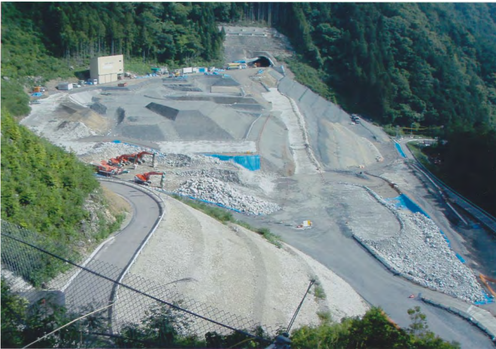
三遠南信大島地区道路建設工事 82点
