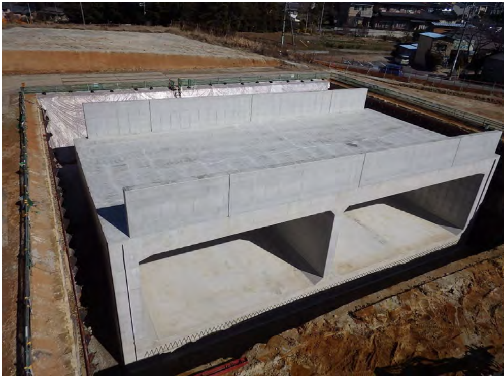
平成25年度155号豊田南BP東新北道路建設工事 80点
