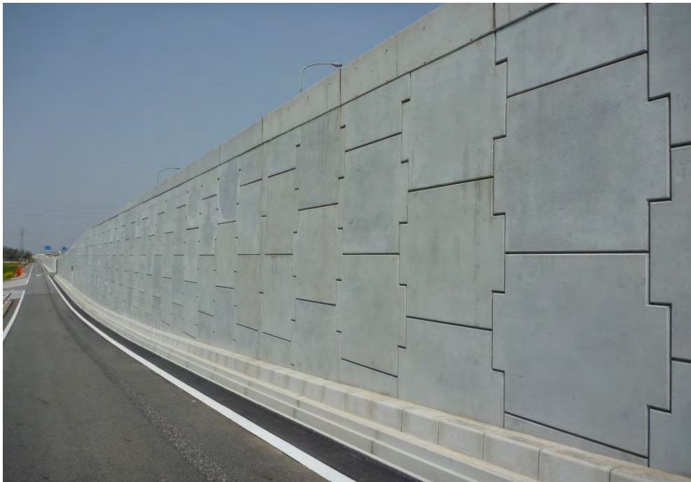
23号岡崎BP藤井道路建設工事 76点
