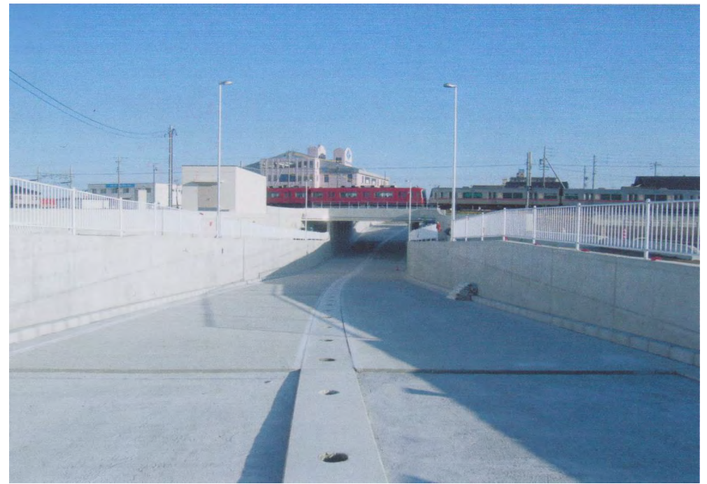
柿田公園線南進道路整備事業 道路築造工事
