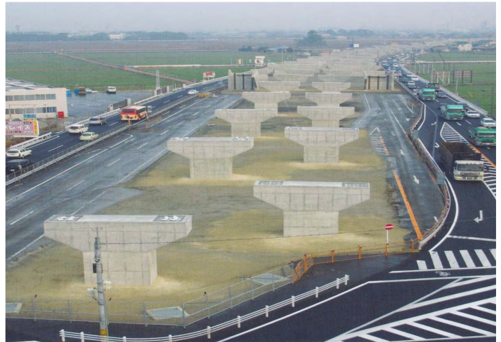
23号知立BP井池高架橋下部工事 82点
