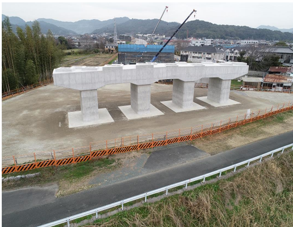
平成30年度23号為当BP為当第4橋下部工事
