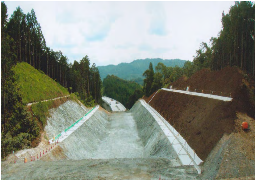
三遠南信別所道路建設工事 81点
