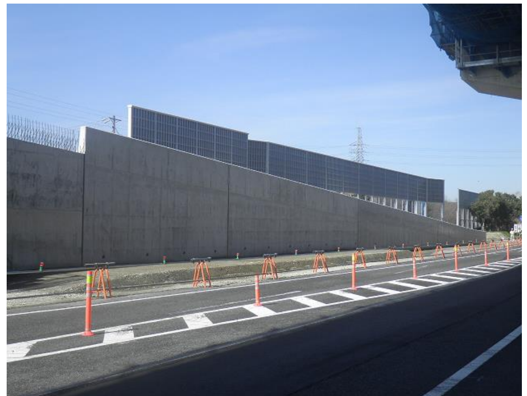
平成30年度名二環富田IC南オフランプ道路建設工事
