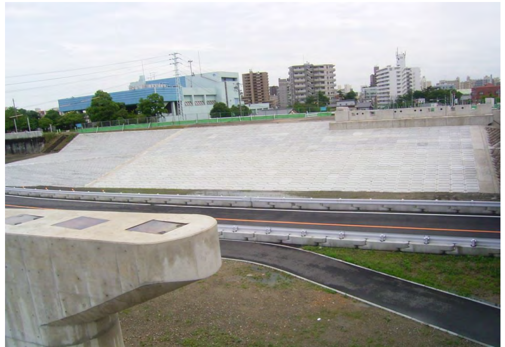
矢田川三階橋橋台工工事 81点
