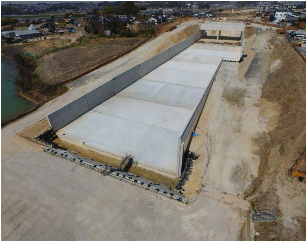
平成28年度 名四国道豊田出張所管内整備工事 78点
