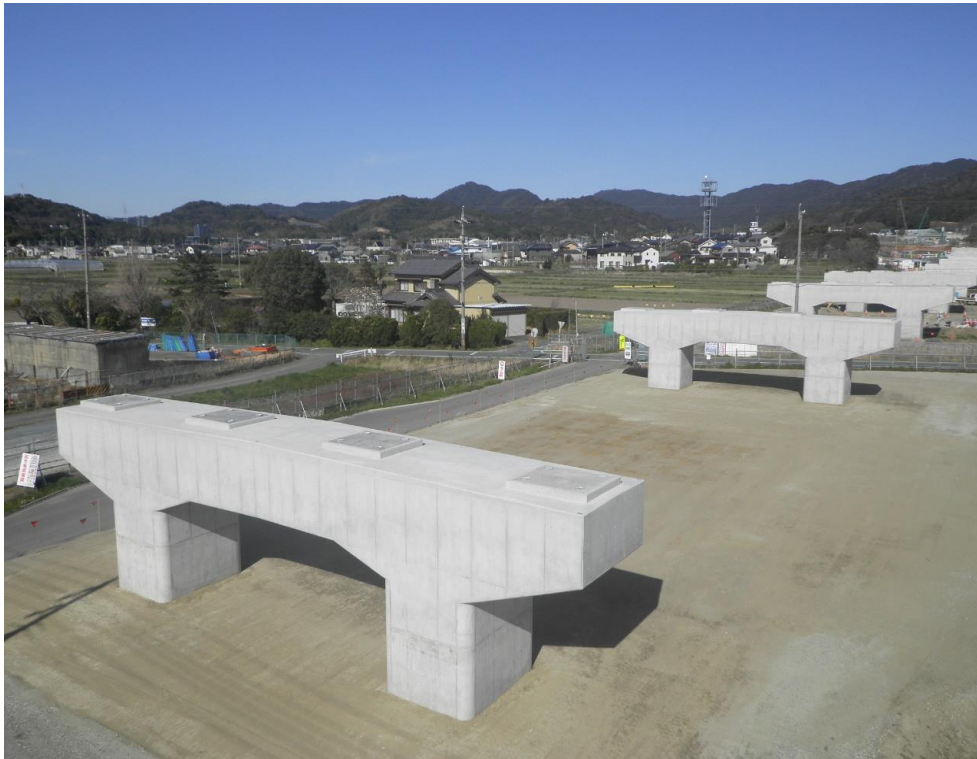
平成29年度23号蒲郡BP為当第1橋東下部工事
