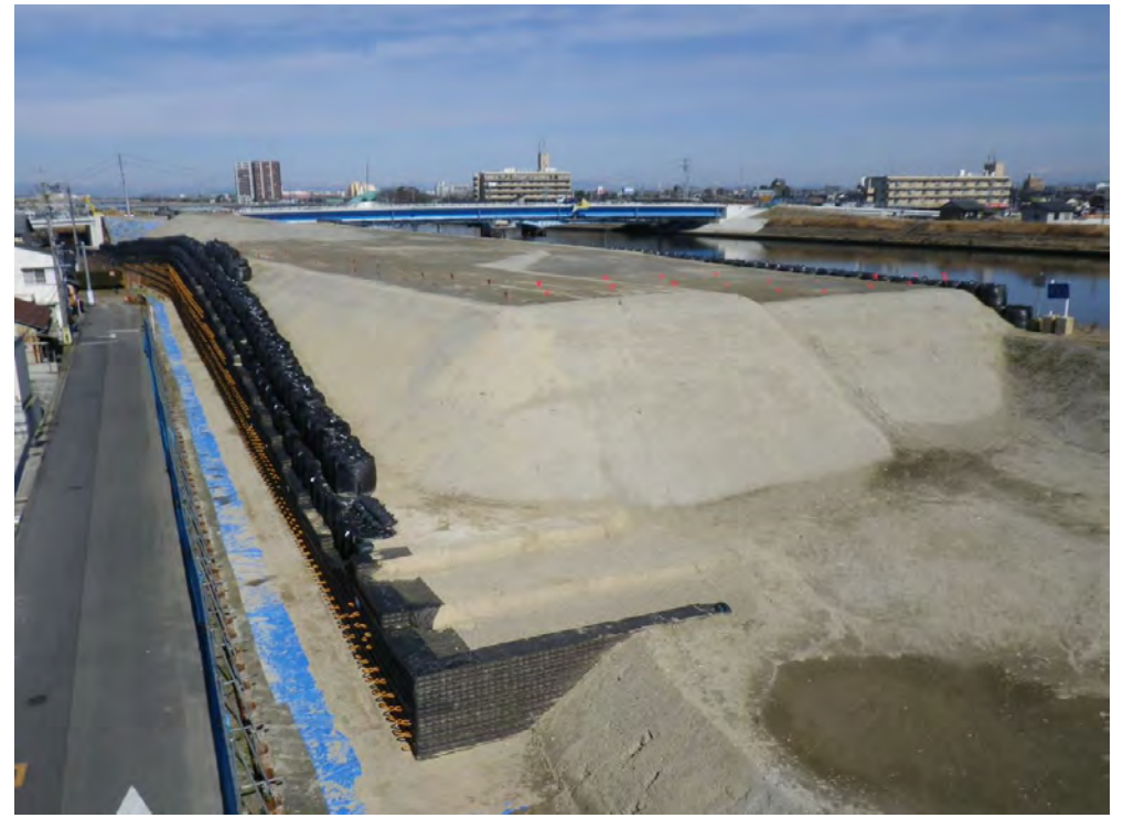
平成26年度1号日光川右岸下流道路建設工事 81点
