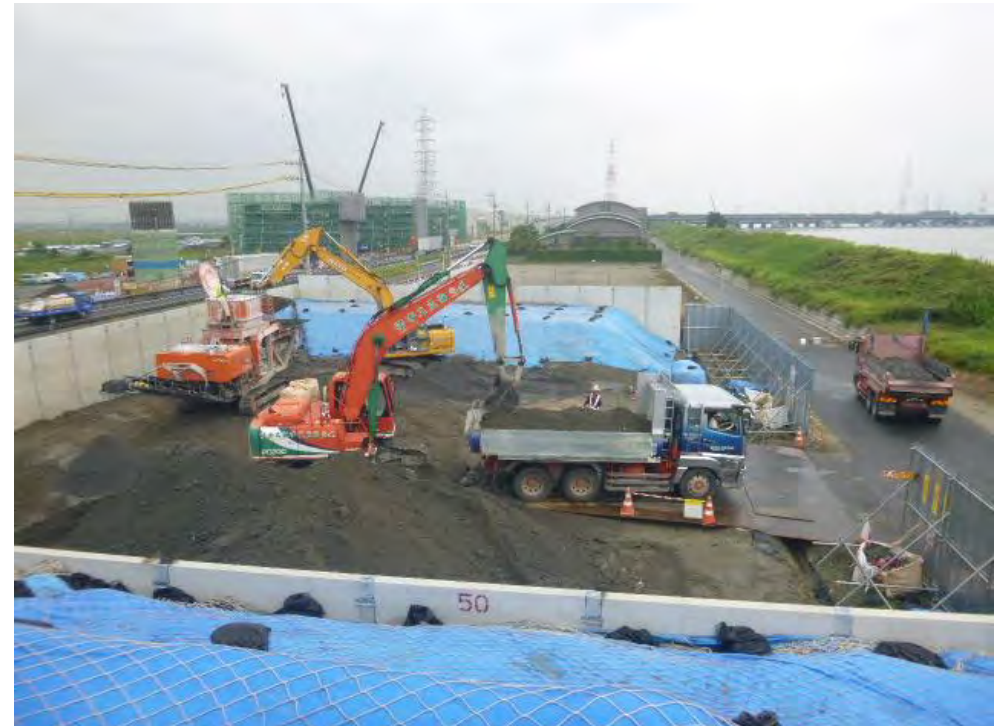
平成27年度302号愛知国道管内道路建設工事 76点
