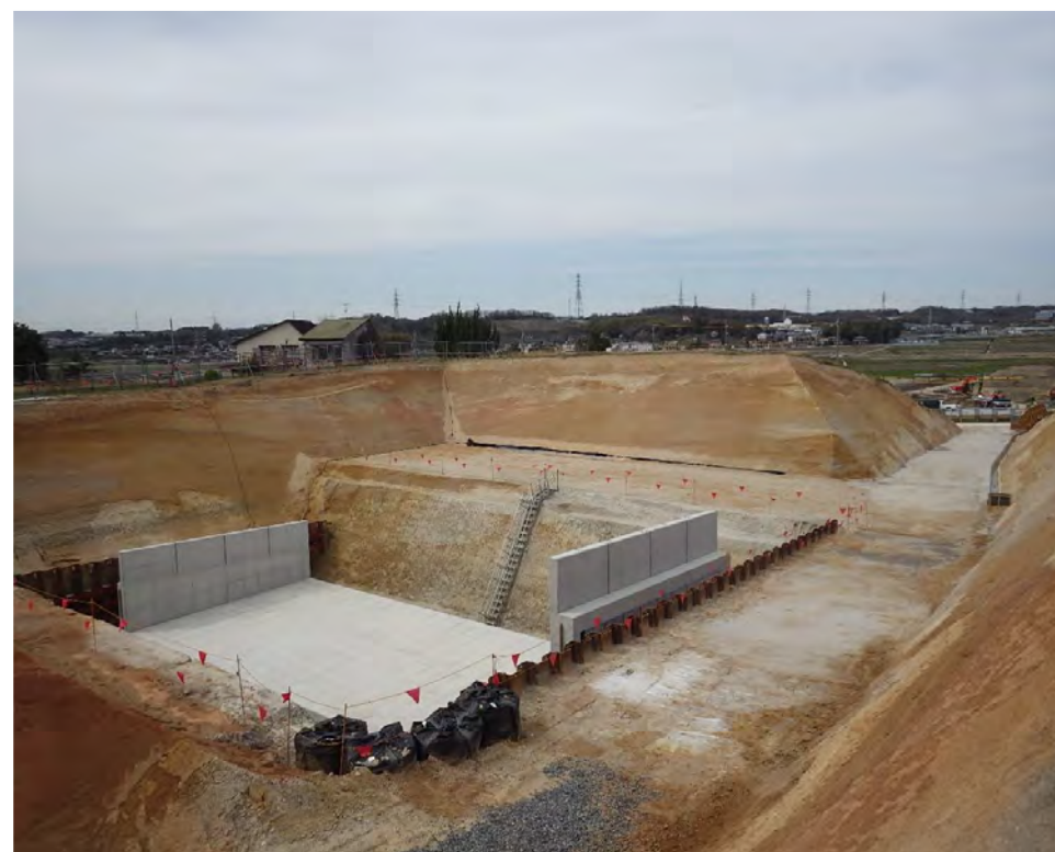
平成29年度 名四国道豊田バイパス整備工事 79点
