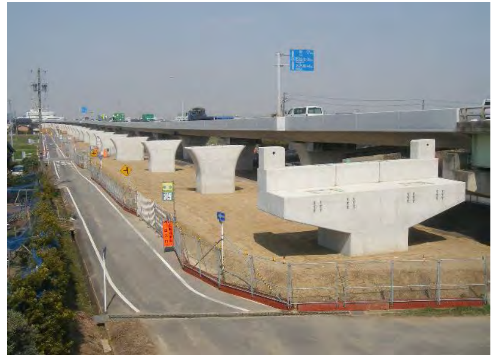
平成25年度23号岡崎BP藤井高架橋東下部工事 80点
