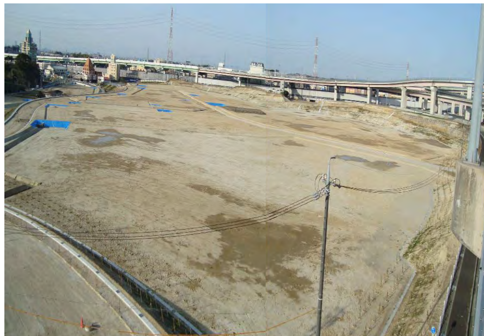
内陸用地造成事業大府木の山地区整地工事
