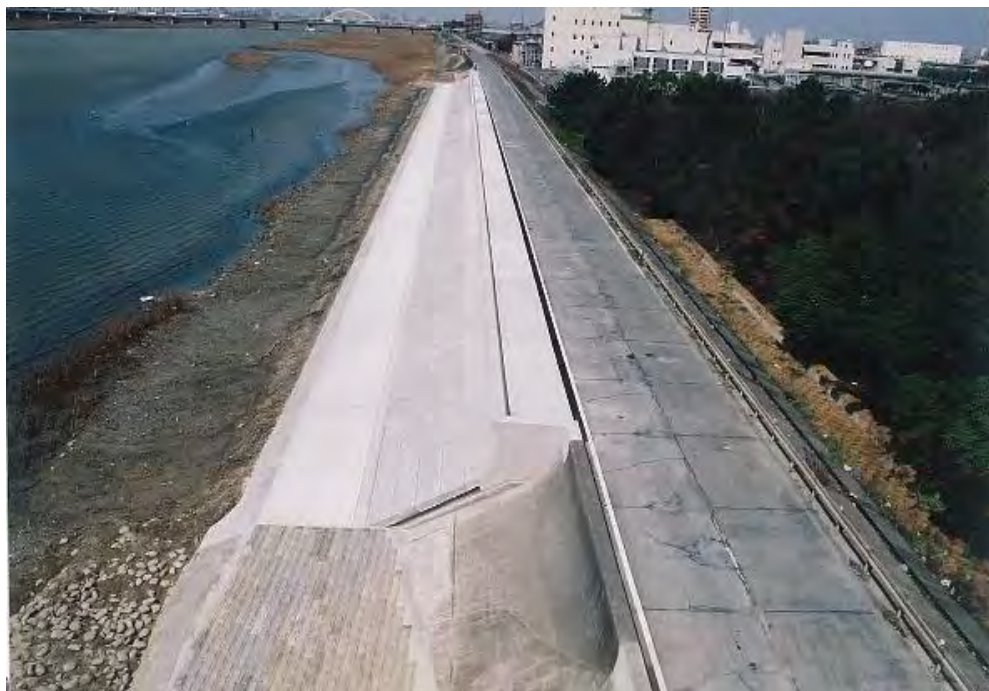
庄内川宝神高潮堤工事 79点
