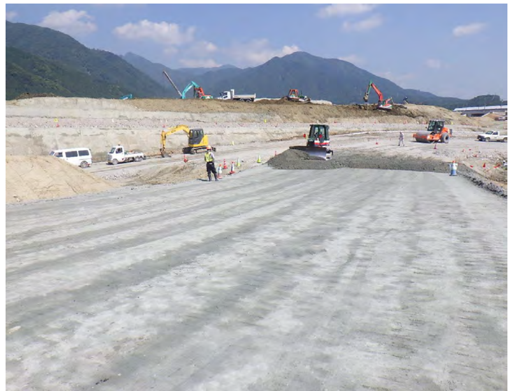
新名神高速道路 鈴鹿PAスマートインターチェンジ工事
