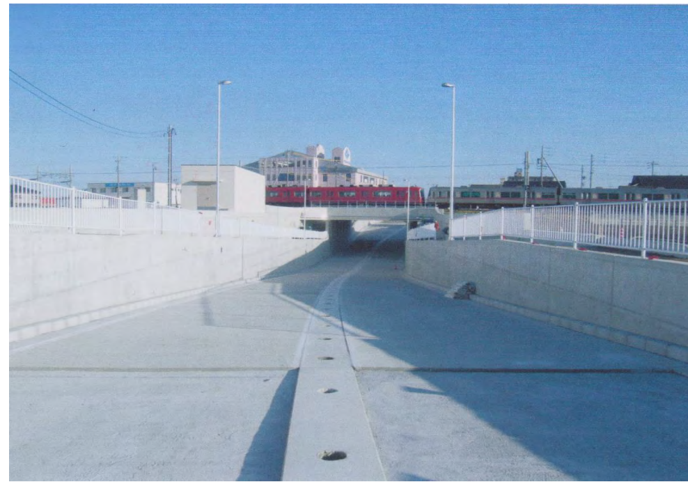
柿田公園線南進道路整備事業 道路築造工事
