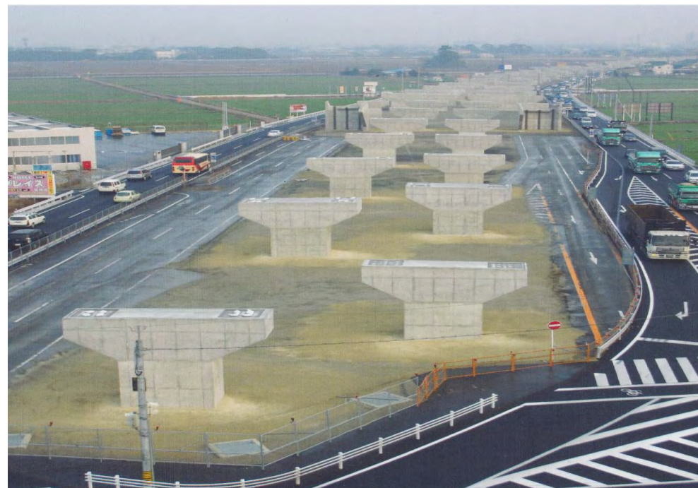
23号知立BP井池高架橋下部工事 82点
