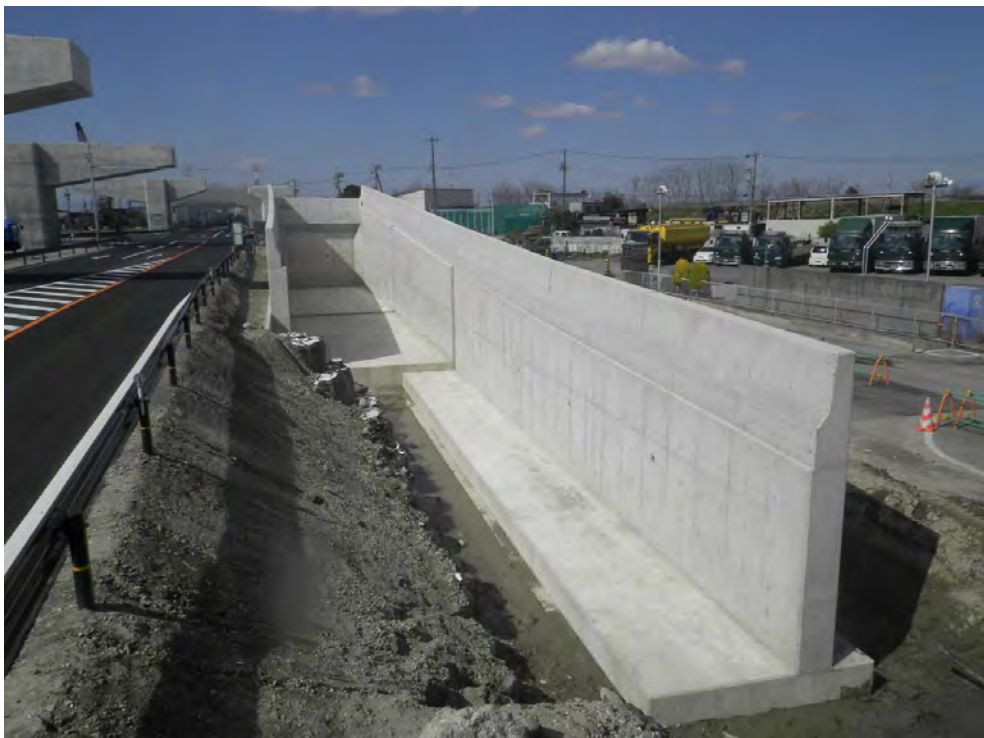
平成27年度302飛島地区道路建設工事 77点
