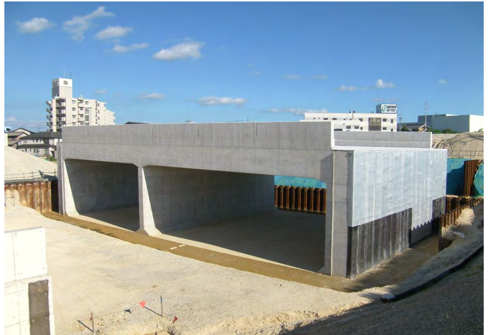
155号豊田南BP柿本道路建設工事 81点
