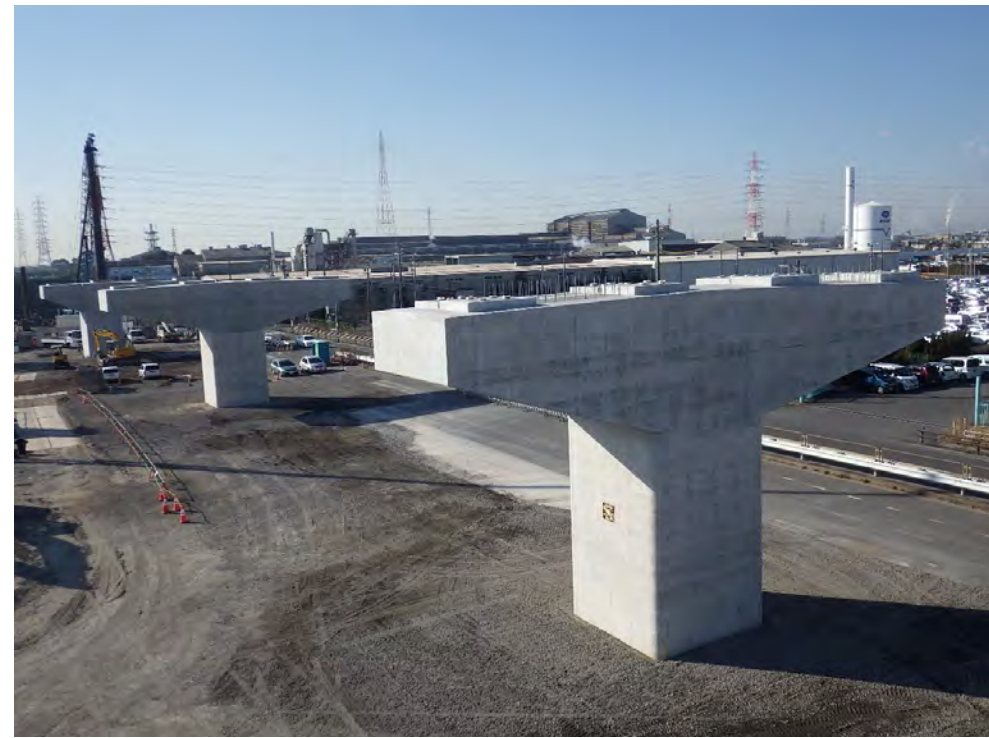
平成26年度名二環新政成1高架橋南下部工事 78点
