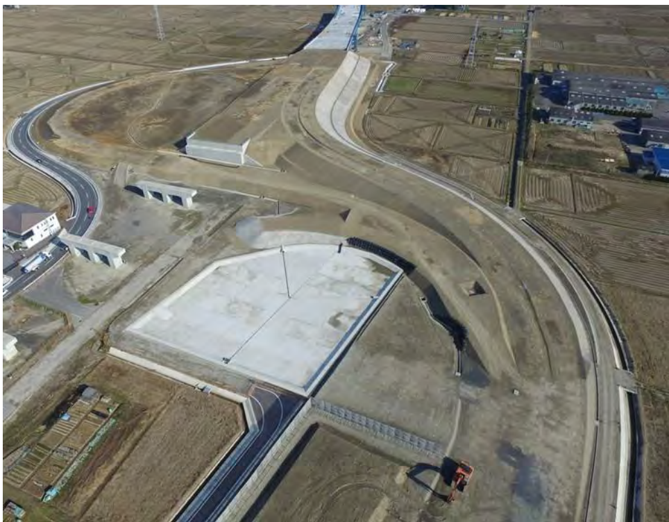
平成27年度 東海環状養老IC東部道路建設工事 79点
