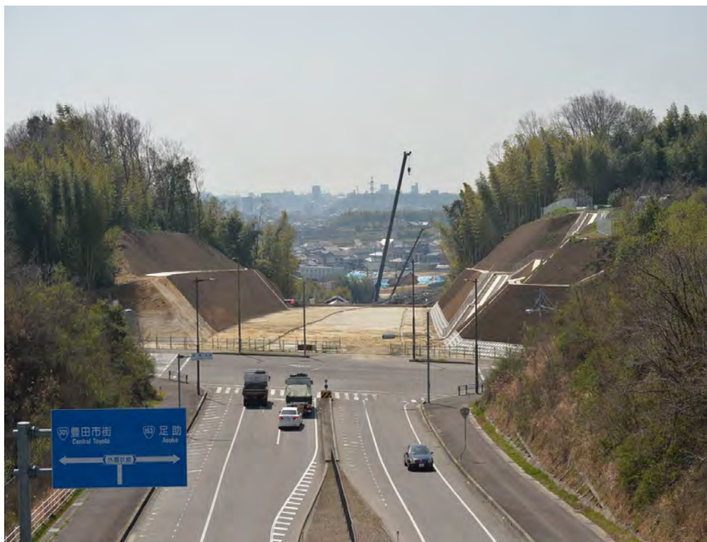
豊田北BP扶桑建設工事 79点
